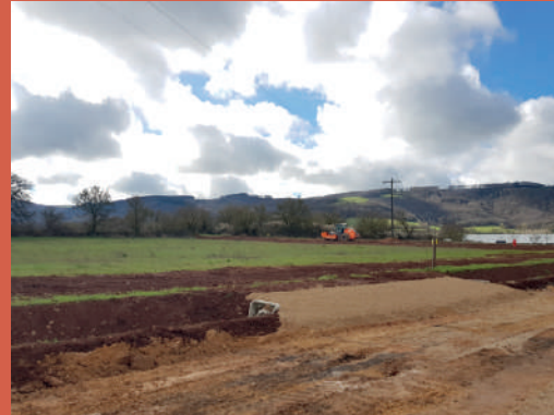
ZAE des Combes, tranche 2, commune de Laissac Sévérac l'Eglise.
