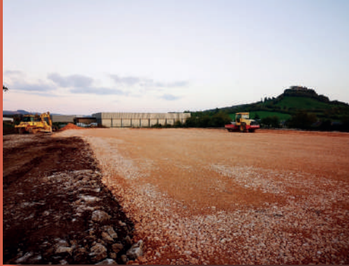
ZAE du Marteliez, tranche 4, chantier de l'entreprise « OXETI », photo A. Laussel
