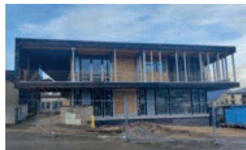
Façade du PIMS en phase travaux, photo CCCA.
