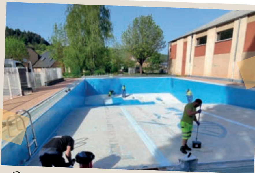
Ponçage et peinture de la piscine
